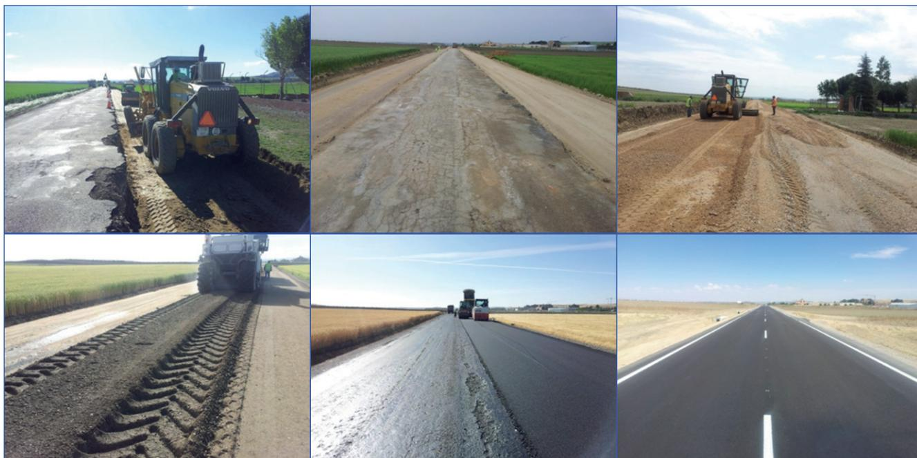
Foto 3. Diversas fases de la rehabilitación reciclando con cemento *in situ*, más mezcla bituminosa en caliente.
