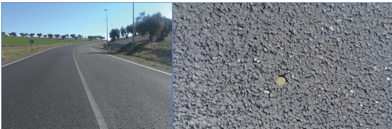
**Foto 7.** Mezcla bituminosa de altas prestaciones tipo SMA realizada en la carretera TO-2542 desde A4 a Ontígola. Aspecto en 2017, tres años después de su extensión.
