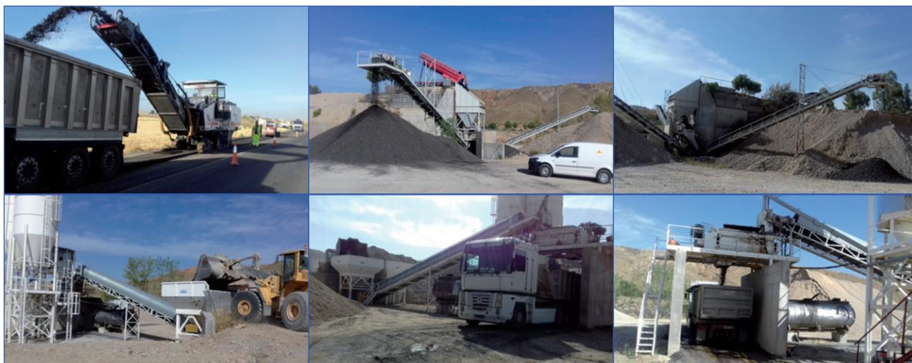
**Foto 5.** Fases de fresado, criba en planta, mezclado y descarga sobre camión en el reciclado en planta con emulsión bituminosa.
