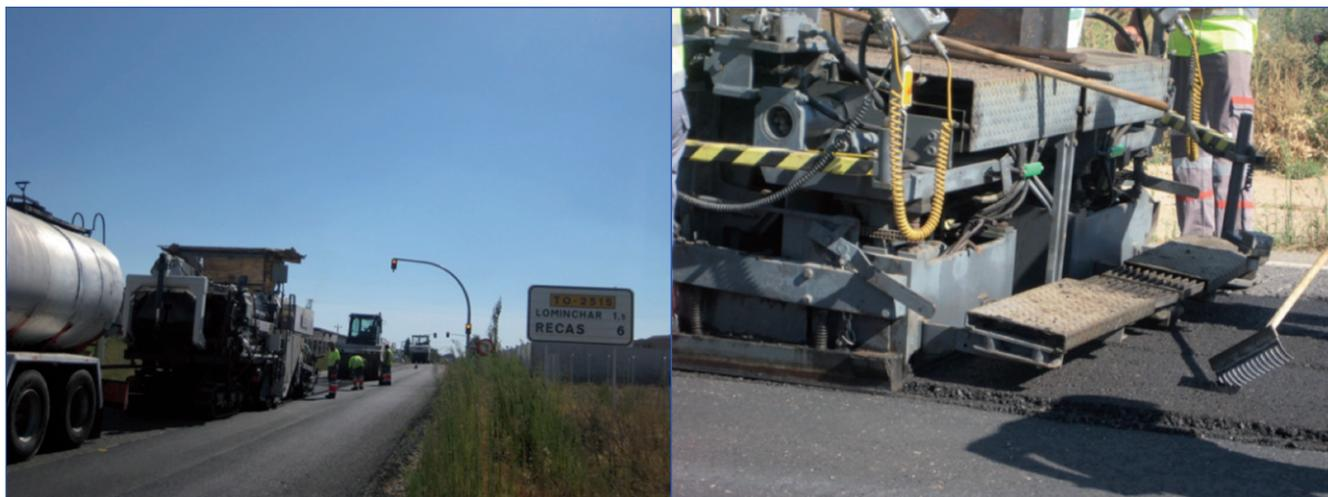
Foto 4. Diversos aspectos de la rehabilitación mediante reciclado *in situ* con emulsión bituminosa.
