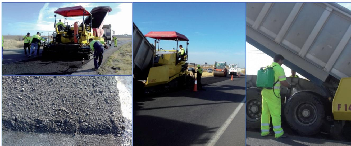
**Foto 6.** Fases de extendido y compactación en el reciclado en planta con emulsión bituminosa. Detalle de limpieza de las ruedas de los camiones para no dañar el riego de adherencia.
