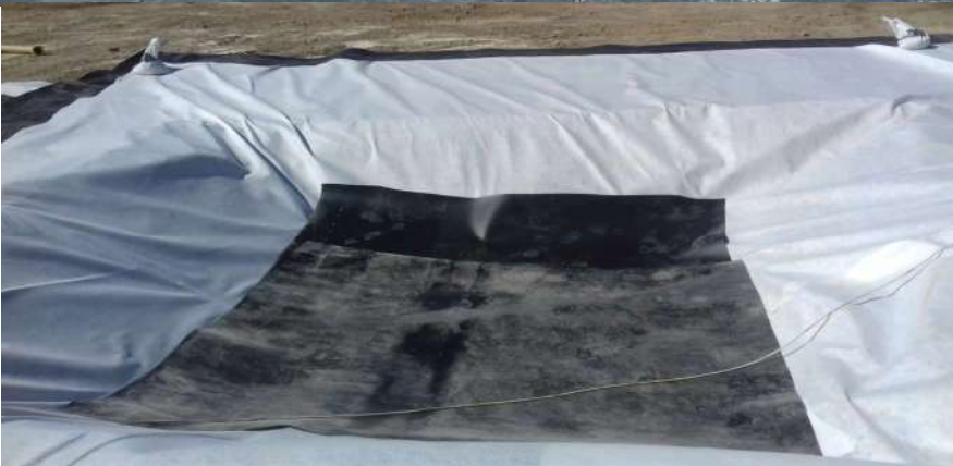
GTX GEOMEMBRANA PERDIDA
