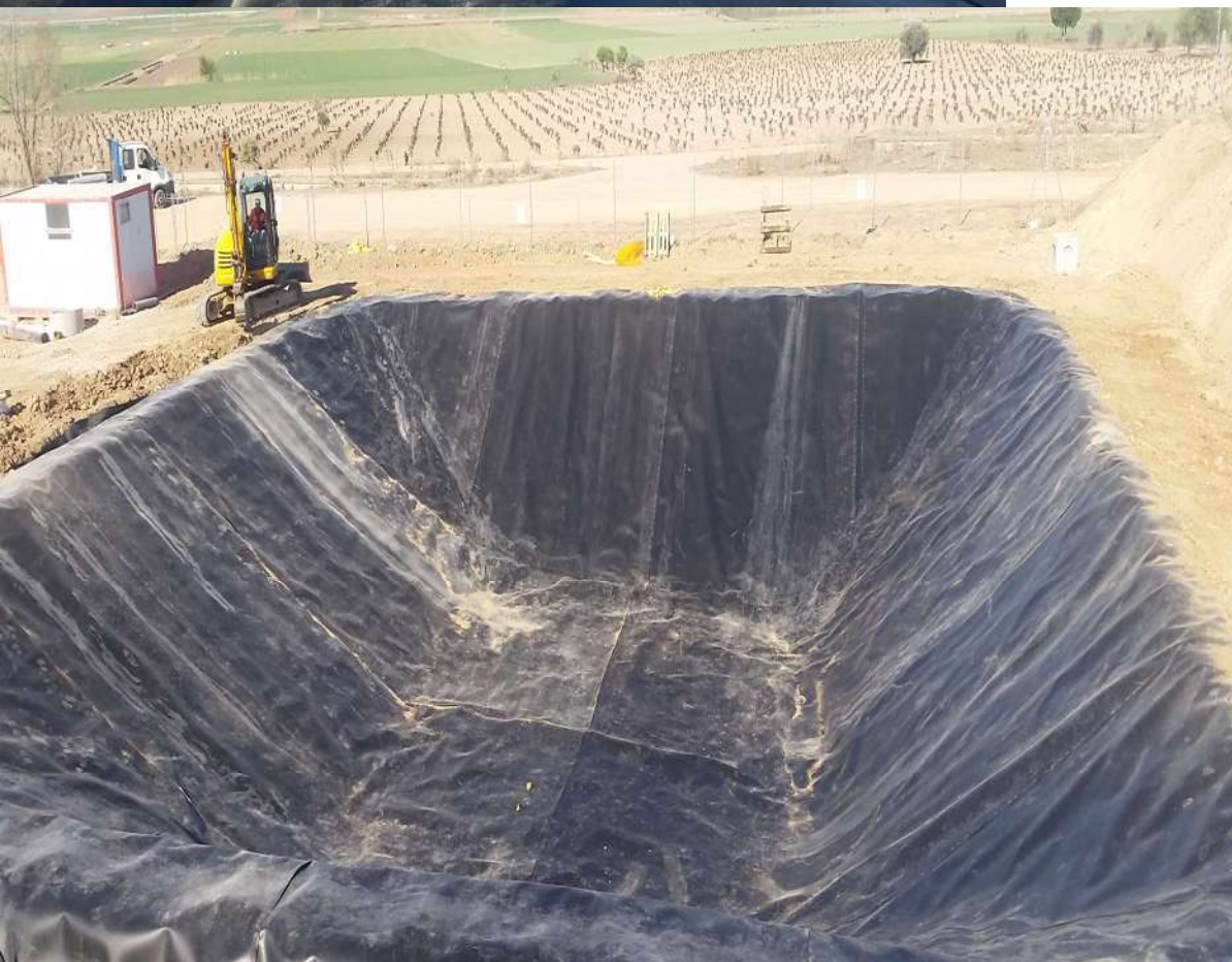
Balsa montada y maquina enterrando zanja de anclaje
