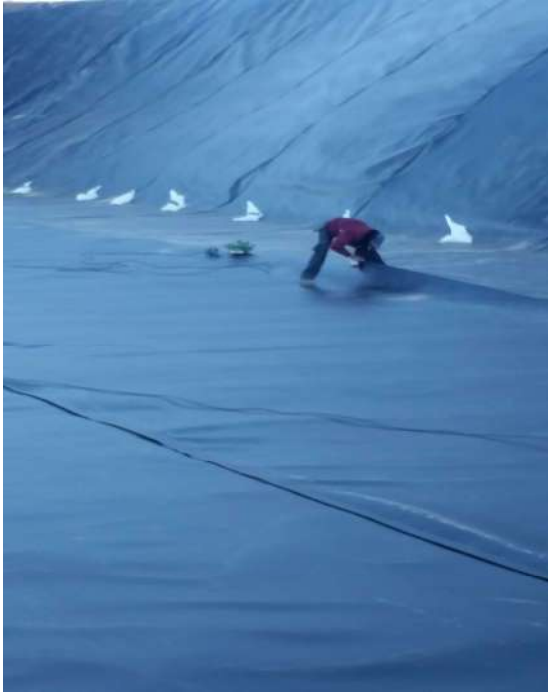
Técnico soldando con maquina automática
