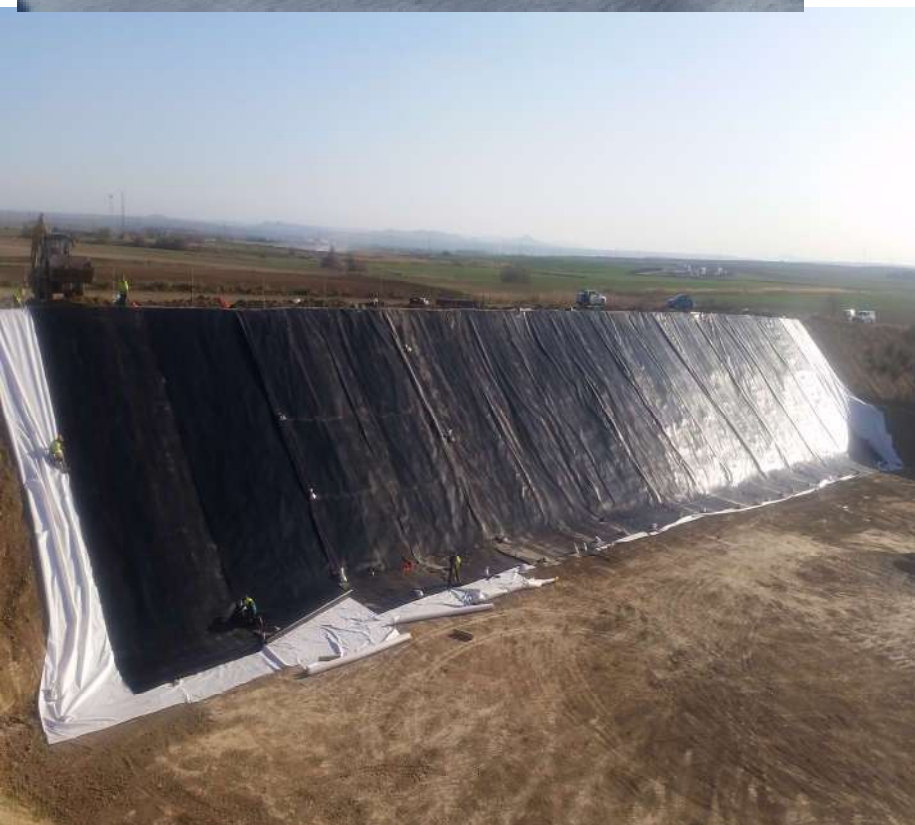
Avance de los trabajos donde se puede apreciar tanto el GTX como la GEOMEMBRANA DE PEAD
