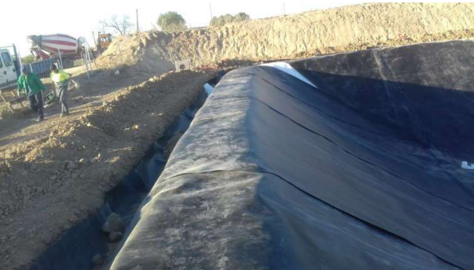
Zanja de anclaje
