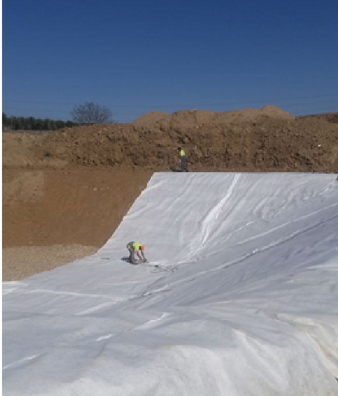
Instalando GTX en balsa para lixiviados
