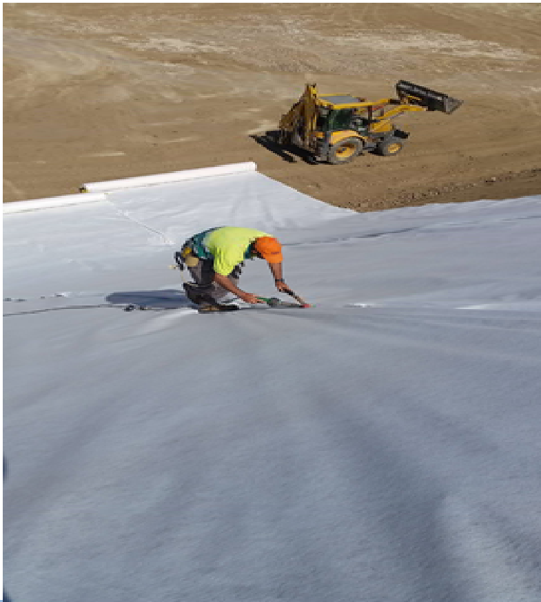
Técnico termo pegando Geotextil
