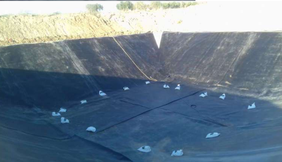
Instalando lamina de PEAD
