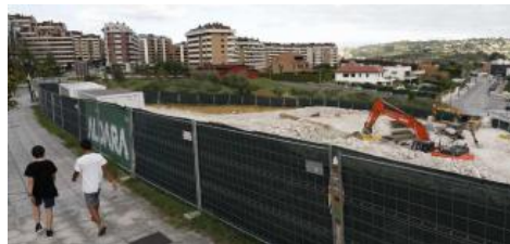
La parcela de la residencia de Montecerrao, en obras. LUISMA MURIAS
